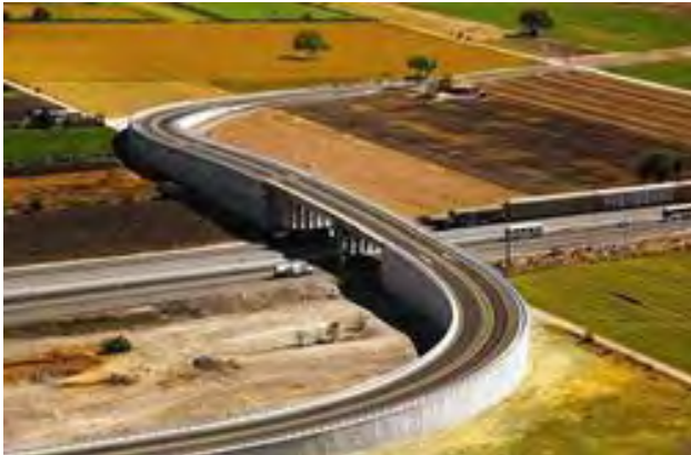
Construcción del paso superior vehicular en el Libramiento Empalme - Comonfort
