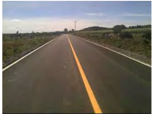
Modernización del camino: Pénjamo Tierras Negras, tramo del km. 8+100 al km. 10+700, en el Municipio de Pénjamo, en el Estado de Guanajuato
