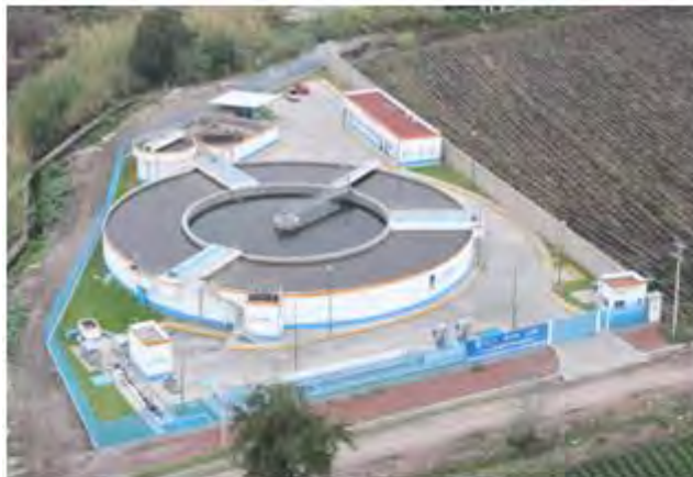
PLANTA DE TRATAMIENTO DE AGUAS RESIDUALES ZACATEPEC, MORELOS
